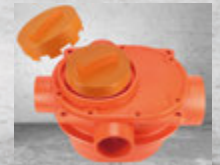
3. 臨時安裝排水管封蓋以阻擋防水膠
