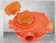
3. 臨時安裝排水管封蓋以阻擋防水膠
