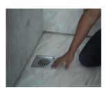
每三個月需定期清理一次,將清潔用的地板落水口 打開,取出不鏽鋼提籃做清潔,請依照使用頻率再 做調整(當排水速度明顯變慢,代表提籃裡的雜物已 經堆滿,請盡快清理)或使用吸水式吸塵器或長柄 工具刷洗底部。
