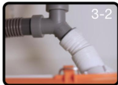
**4** 再將配件排水軟管銜接於截油槽出水口，以管束鎖緊(4.1)。
