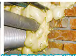
使用填縫劑確實填縫
