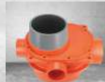
2. 臨時插接5"排水管，阻擋水泥漿。
