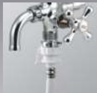
接洗衣機給水口 及套接彈性水管
