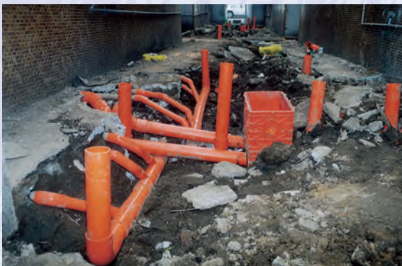
▲ 下水道工程 Sewer Engineering
