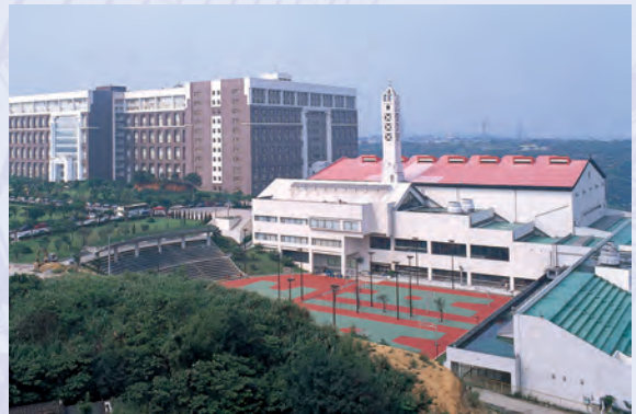
▲ 建築工程 Construction engineering
