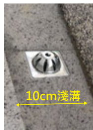
PD754 新品 露台落水頭 尺寸：9.5x9.5x1.5cm 口徑：2"
